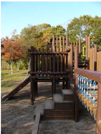
←柱脚部は金具を使用し、木部が地面に接しない構造
