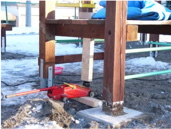
手順1 柱の切断に備える
