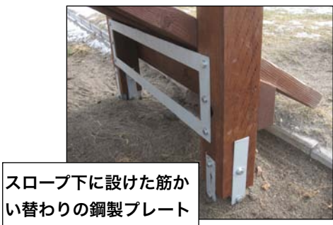
写真2-1-3 筋かい設置における特殊例
