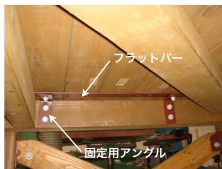
写真1-3-4 梁への固定状況（床下）
