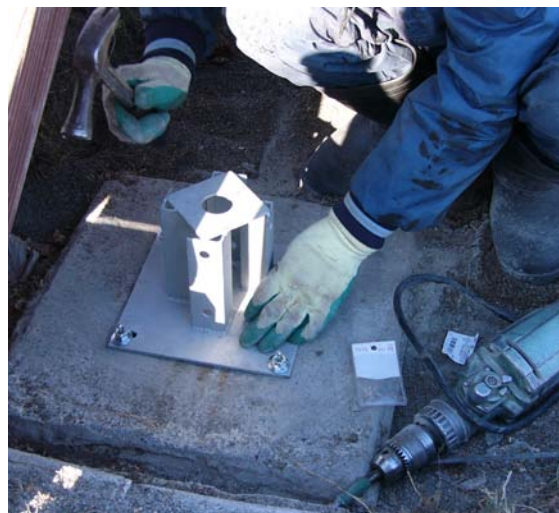
手順6 嵩上げ金具の取り付け
