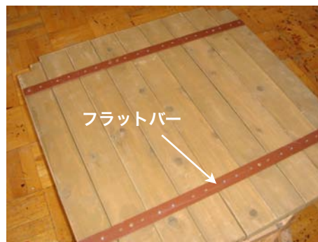
写真1-3-2 床のユニット化（裏面）
