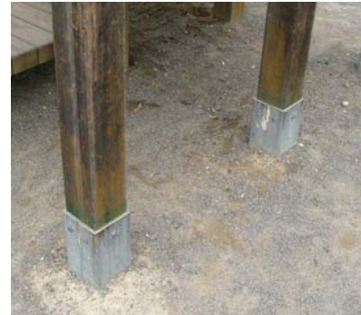
写真 2-1-1 鋼板を使った補修例
