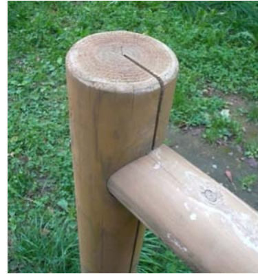
写真1-4-1 支柱への横木の差し込み
