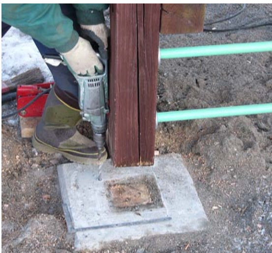
手順5 後付けアンカー用穴あけ
