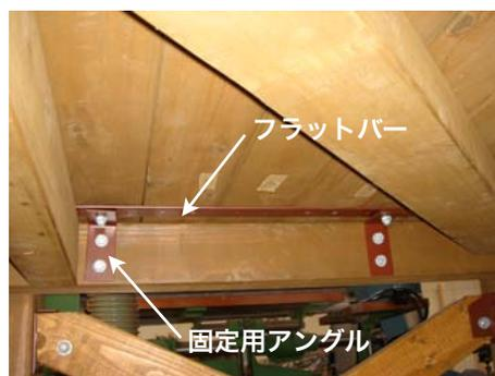
写真1-3-4 梁への固定状況（床下）
