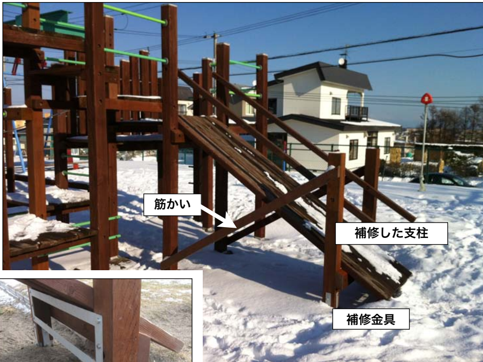
スロープ下に設けた筋かい替わりの鋼製プレート
