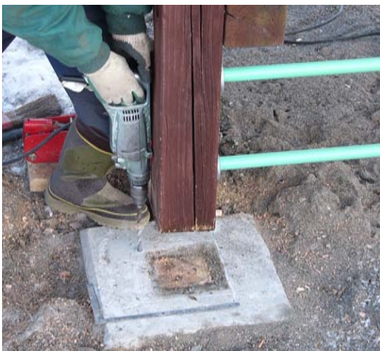
手順5 後付けアンカー用穴あけ
