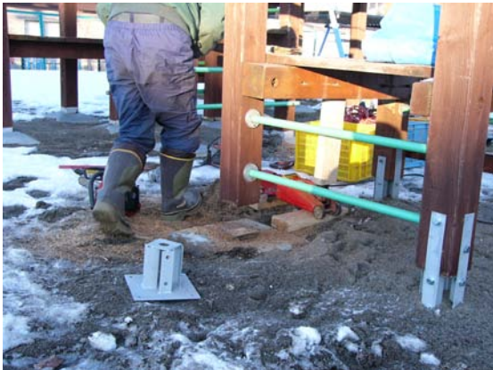
手順3 支柱腐朽部の撤去状況
