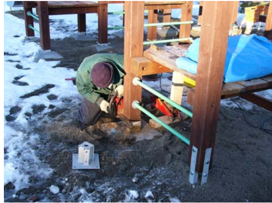
手順2 支柱腐朽部の切断
