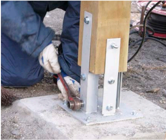
手順7 平金具で柱を緊結
