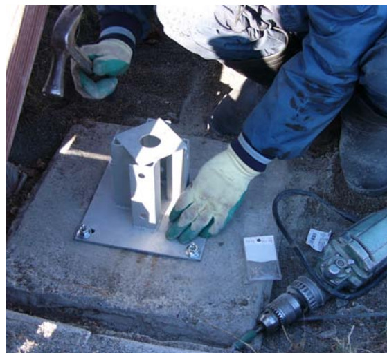
手順6 嵩上げ金具の取り付け
