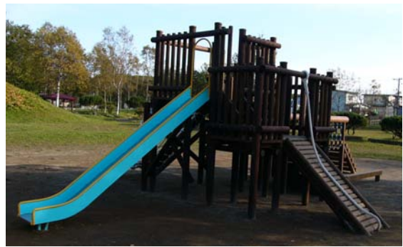
←柱脚部は金具を使用し、木部が地面に接しない構造
