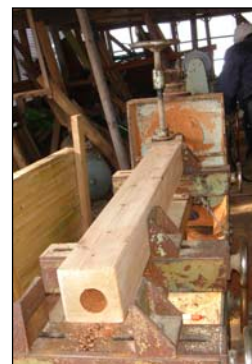
・木口面の脚部接合金具挿入孔加工
