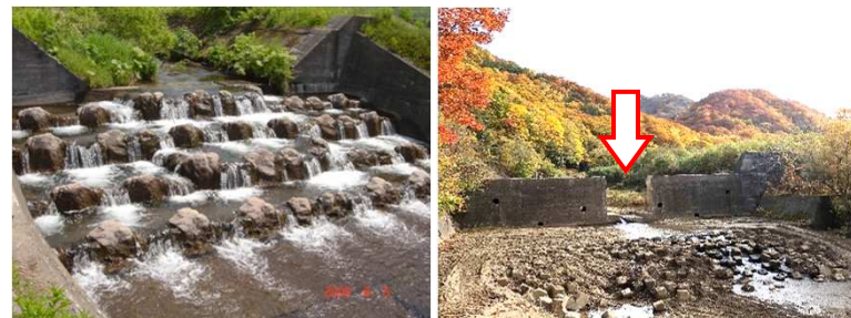
落差工に設置された魚道 (白井川、尻別川水系、後志管内)
