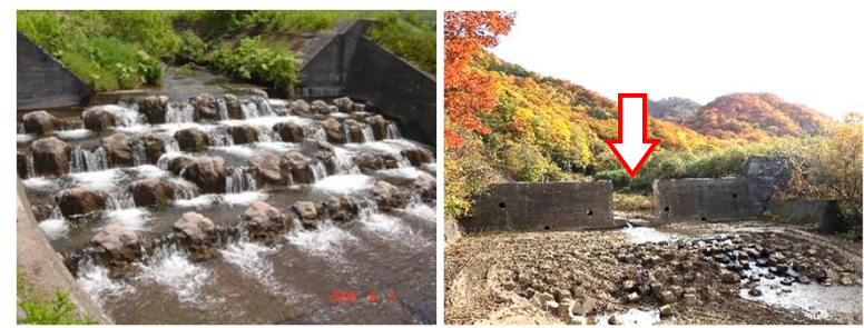
落差工に設置された魚道 (白井川、尻別川水系、後志管内) スリット化された砂防ダム(折川、後志管内)
