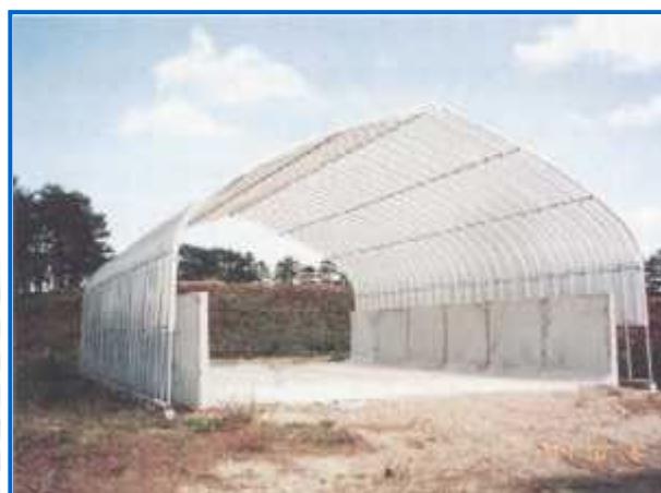
パイプハウス堆肥舎
