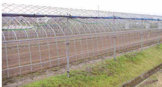
写真IX-4 防風網（ハウス側面）設置の様子 (上川中部地区農業改良普及センター撮影)
