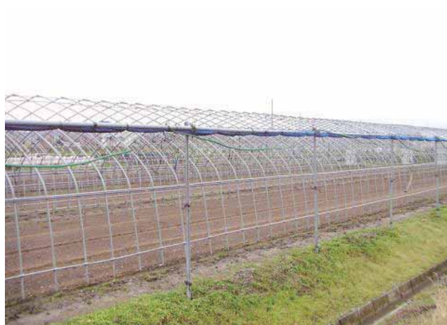
写真IX-4 防風網（ハウス側面）設置の様子 (上川中部地区農業改良普及センター撮影)
