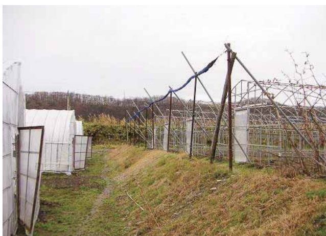
写真IX-5 防風網（ハウス妻面）設置の様子 (上川中部地区農業改良普及センター撮影)
