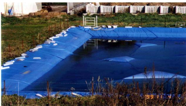
写真1 雨水分離シート設置直後(1998.6.30)
