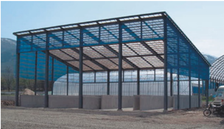
試験堆肥舎の外観 (4区画のうち右の2区画が排汁促進構造)
