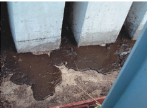
壁のスリットから流出し始める排汁
