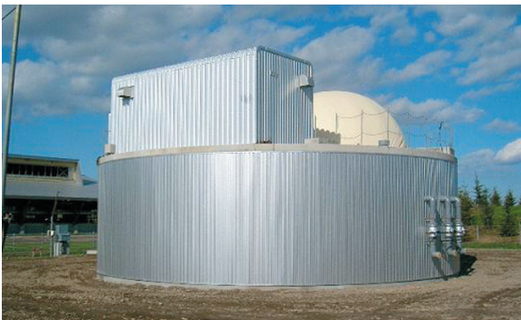
大小2つの発酵槽を1つの建物内に一体化したバイオガスプラントです。原料ふん尿はまず小さな発酵槽（連続式発酵槽）にて約40℃でメタン発酵したのち、大きな発酵槽（貯留式発酵槽）へ移動して、引き続き約20℃でメタン発酵しつつ散布まで貯留されます。
