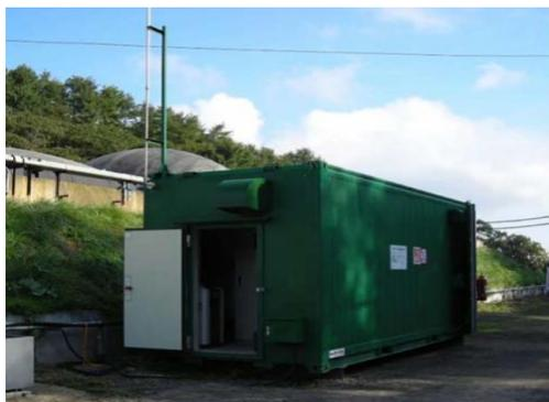
左：余剰バイオガス精製圧縮充填装置
