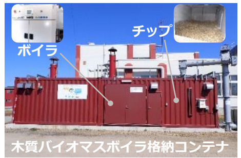
施設更新時に重油ボイラから木質チップボイラへ転換した小学校
