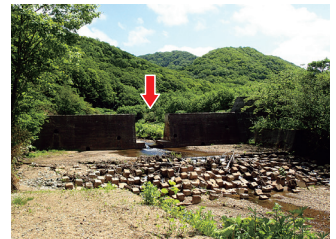
中央を切り下げた砂防ダム(スリット化)
