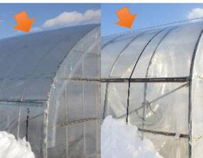
**空気膜 (左)** : ハウス屋根外張部分にフィルムを二重に張り2層の間に送風するため、外張が浮き上がる(右は通常の外張)
