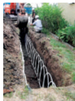
水平探熱方式（地中熱ヒートポンプ）
