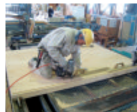
パネル組立試験
