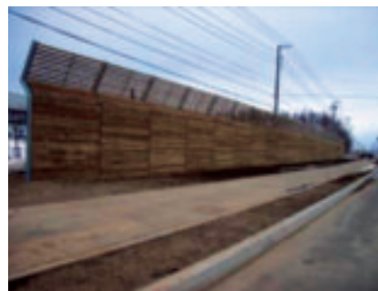
高性能木製防雪柵の開発(道道225号)
