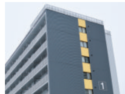
格子フェンスを設置した公営住宅
