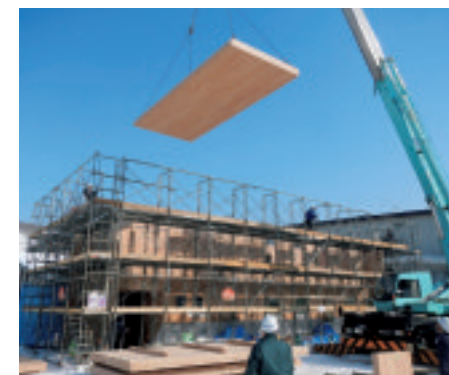
CLT を用いた建築物が道内で初めて建設されました。
