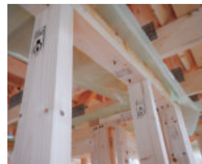
道産ツーバイフォー製材が採用された住宅の骨組み
