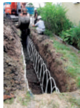
水平探熱方式（地中熱ヒートポンプ）
