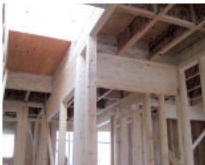
輸入材で建設されるツーバイフォー工法住宅
