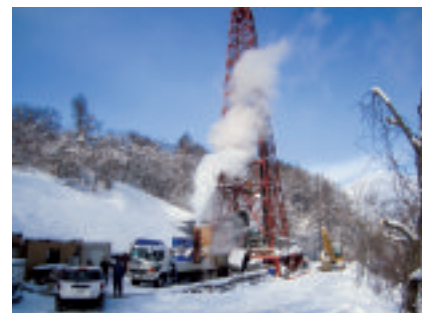
左：湯気が沸き立つ新たな地熱井の様子
