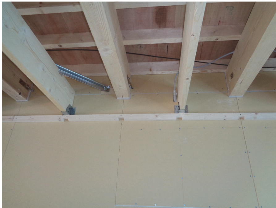
写真 5-1 独立天井の天井下地の例 (在来構法)
