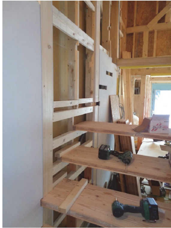
写真 5-3 振動伝達を防ぐ踏板の施工方法
