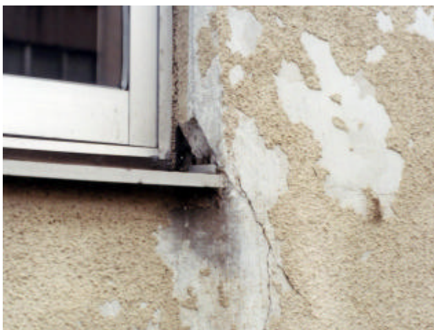
写真 3 - 1 A : 躯体劣化、B : 仕上材のみの劣化の考え方
