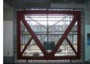
【補強】特付き鉄骨プレスを設置する工法の例
