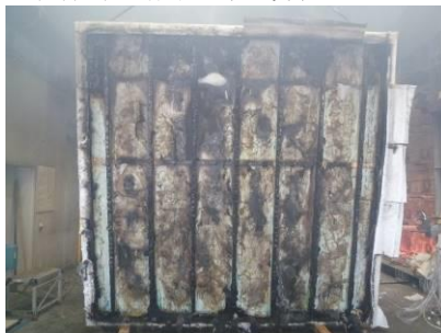
試験体加熱面（終了後）
