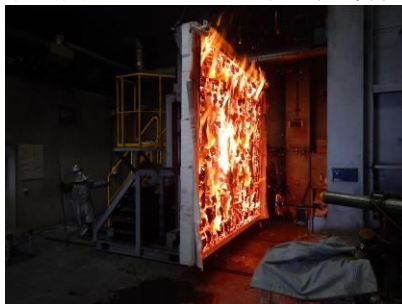
試験体加熱面 (終了後)
