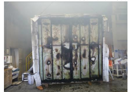
試験体加熱面 (終了後)
