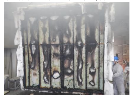
試験体加熱面（終了後）
