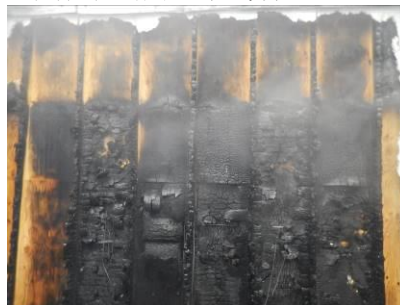
試験体加熱面（終了後）
