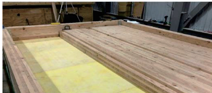
図4 浮き床層の施工状況
