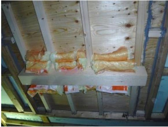
写真 2-13 床下からの気流止め挿入状況①
