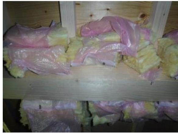
写真 2-14 床下からの気流止め挿入状況②
