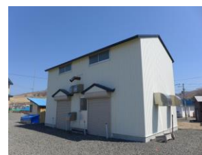
昆布森 A 乾燥庫 写真1 乾燥庫外観
