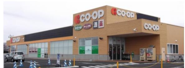
写真2 実測調査を行った実建物
