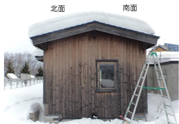
写真2 屋根雪観測を行った実建物
