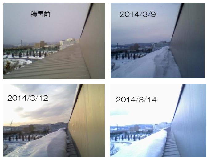
写真1 外装部材（庇）の融雪状況
