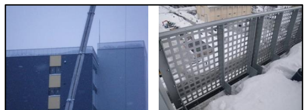
写真1. 格子フェンスによる屋根雪対策例
