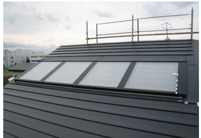
写真1 北総研実験棟に搭載した集熱器
