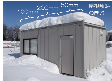
写真1 実験建物（旭川）
