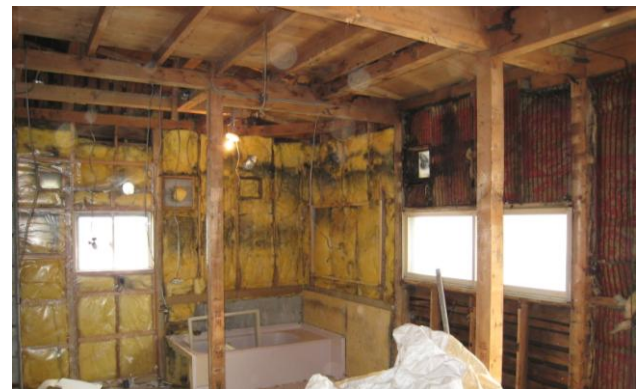
写真1 グラスウール採取現場の例（昭和49年築）
