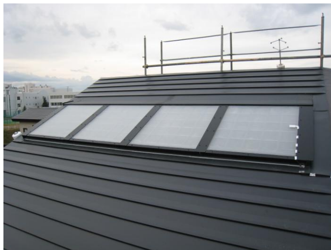
写真1 北総研実験棟に搭載した集熱器
