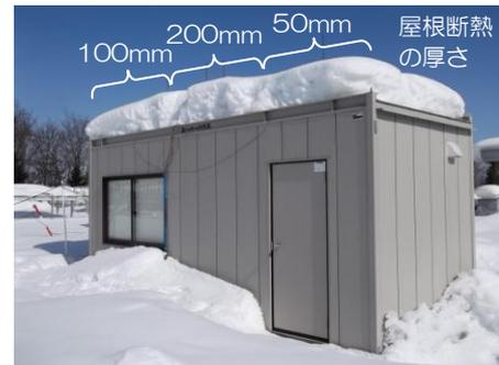
写真1 モデル検証用実測建物
