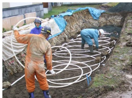
図3 水平採熱式ヒートポンプ（採熱管設置）
