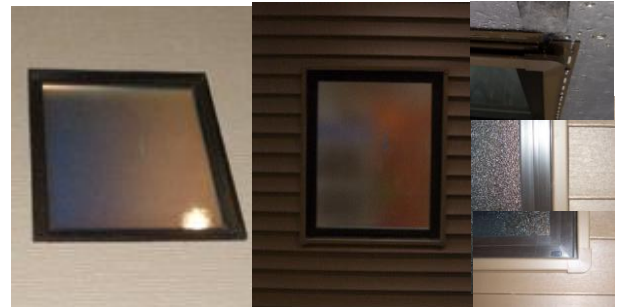
図1 断熱改修試行（窓周り）
