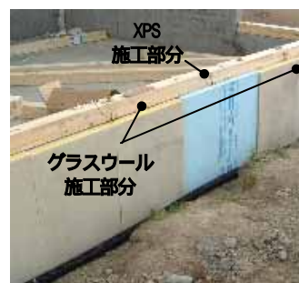
基礎に施工されたグラスウールと押出法ポリスチレンフォーム板
