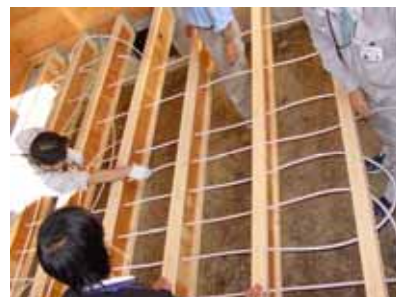
温水管の敷設実験
