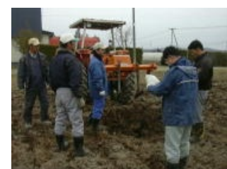
写真3 スーパーソイラーの施工
