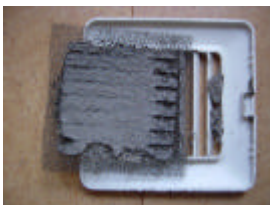
室内の吸い込み口は目づまりしている。
