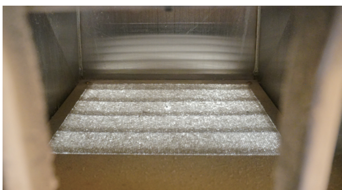
写真3 フードの防虫網に堆積したホコリ
