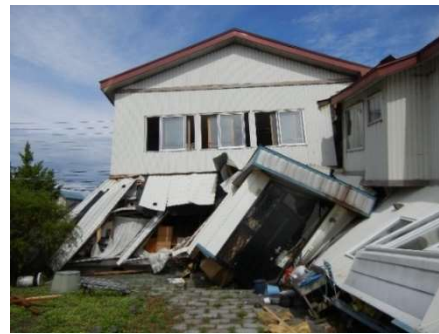
写真4-7 店舗併用住宅の倒壊被害
