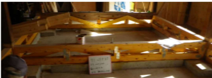
写真 6-2 床梁補強の施工例
