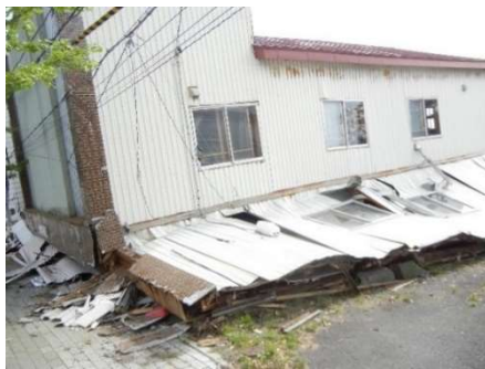
写真4-7 店舗併用住宅の倒壊被害
