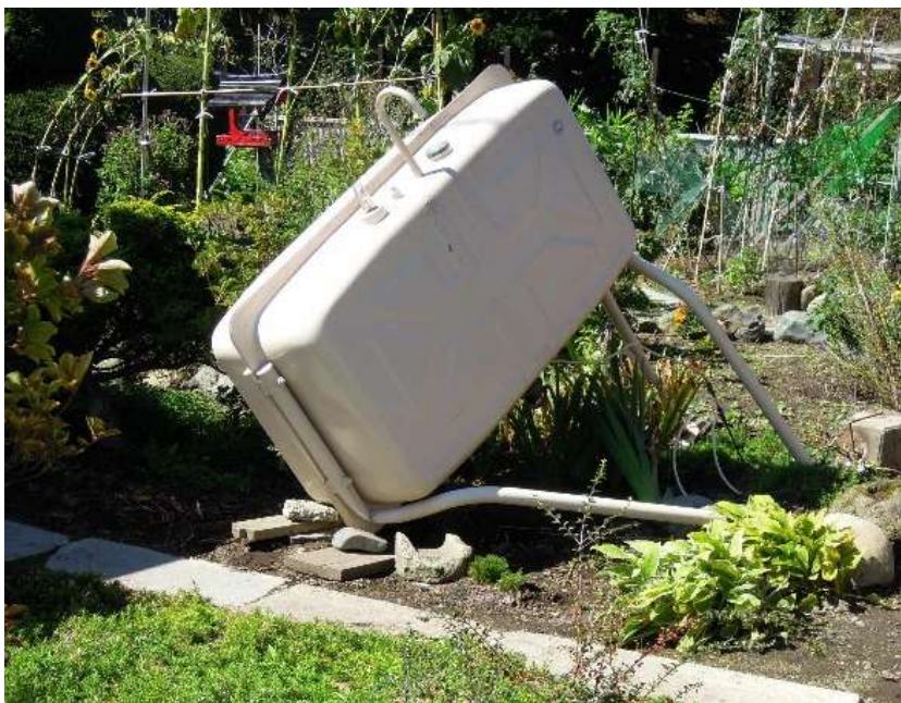
写真 7-2 地震による灯油タンク転倒被害
