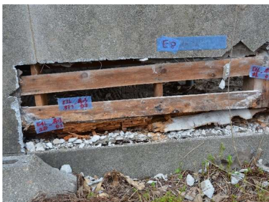
写真 4-6 解体住宅における部材の腐朽状況
