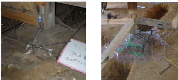
写真 6-1 独立柱の基礎補強の施工例
