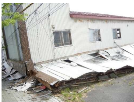
写真4-7 店舗併用住宅の倒壊被害
