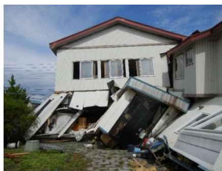
写真4-7 店舗併用住宅の倒壊被害
