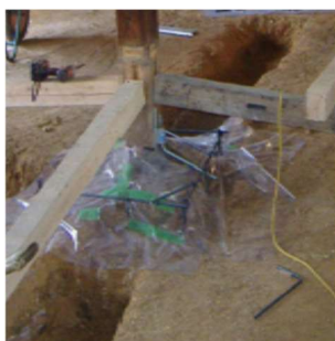
写真 6-1 独立柱の基礎補強の施工例
