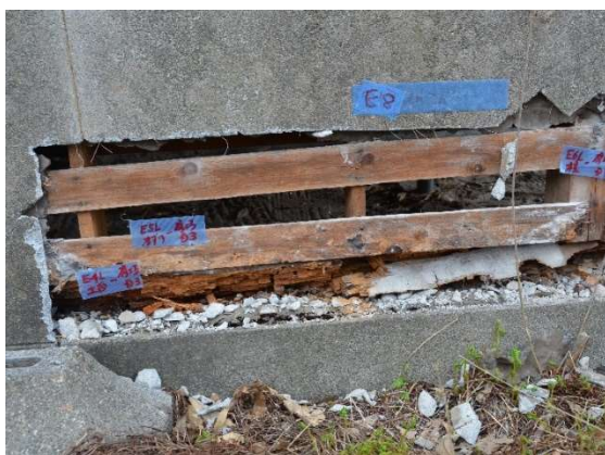
写真 4-6 解体住宅における部材の腐朽状況
