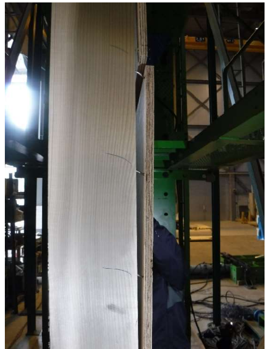
(b) 釘の引き抜け破壊
