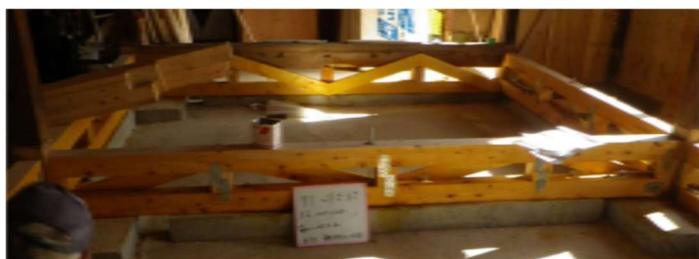
写真 6-2 床梁補強の施工例
