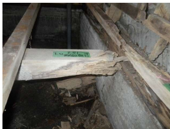
写真 4-6 解体住宅における部材の腐朽状況
