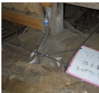
写真 6-1 独立柱の基礎補強の施工例
