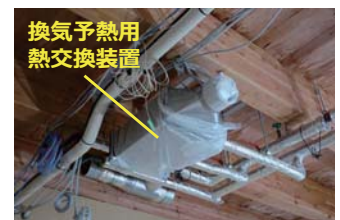
写真2 実装された熱搬送技術
