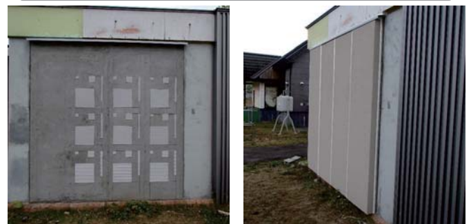
図2 模擬浮き配置状況および外断熱施工後外観
