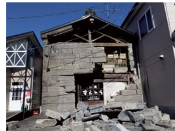
写真2 混構造被害
