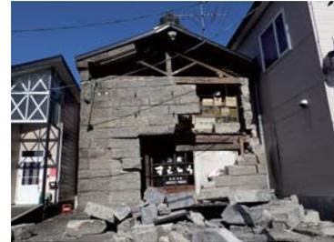
写真2 混構造被害
