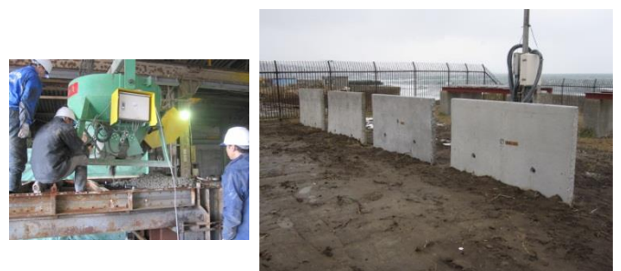
図-3 二次製品製造状況とモニタリング状況
