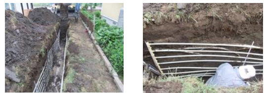
図2 地中熱交換機の設置
