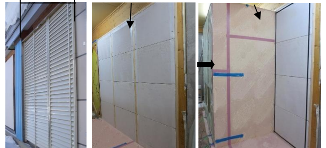
写真1 実験建物のBIC壁構造・呼吸型DIの試験施工
