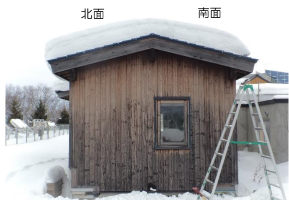
写真2 屋根雪観測を行った実建物
