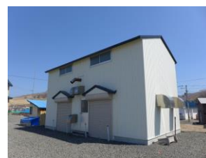
昆布森 A 乾燥庫 写真1 乾燥庫外観
