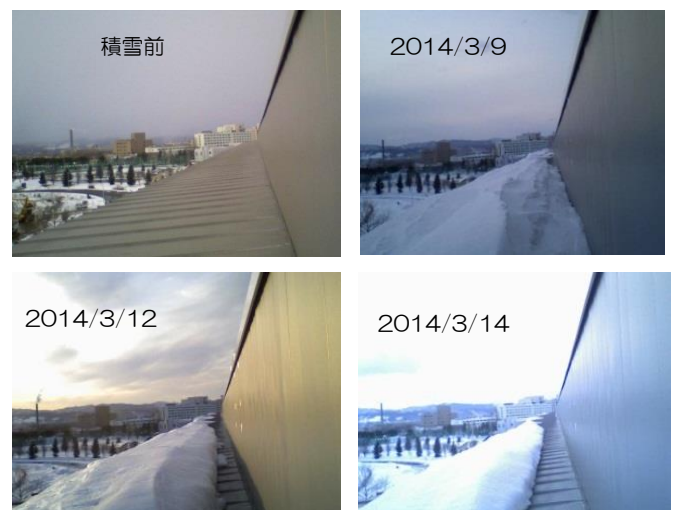
写真1 外装部材（庇）の融雪状況
