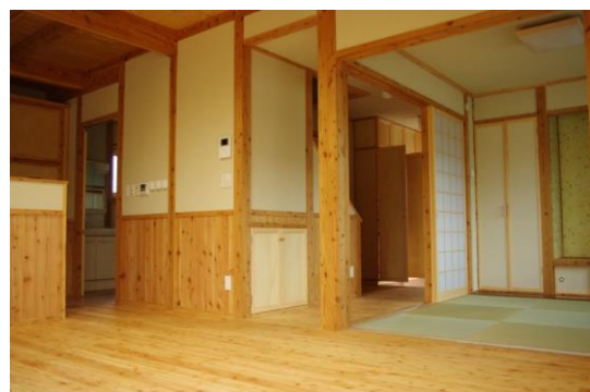
写真2 道産材を活用した実証住宅の建設
