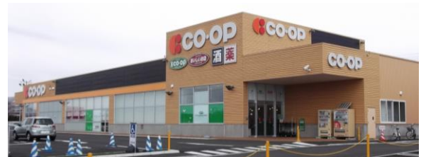
写真2 実測調査を行った実建物
