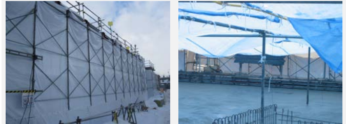
図1 寒中コンクリート工事施工状況
